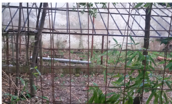
Fig. 19 – Immagini della tettoia e della serra dopo l'intervento (foto del 03 febbraio 2017)
