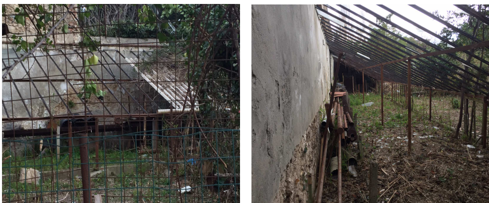
Fig. 18 – Immagini della tettoia e della serra prima dell'intervento
